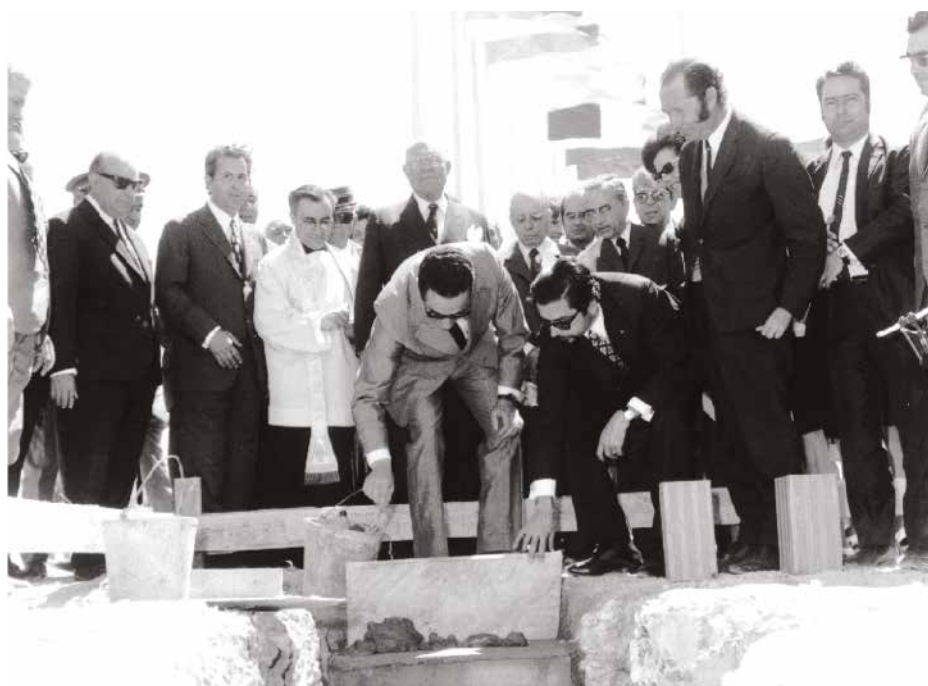
Comendador Joaquim Baraona nas obras do Hospital de Cascais
